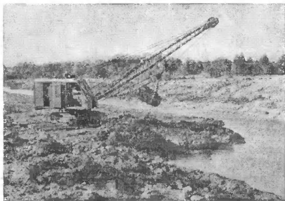
Мелиоративные работы на реке Пайде
